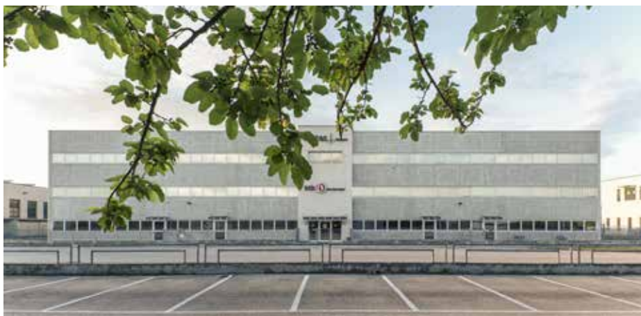
Sede centrale di BTK - NORD ITALIA
